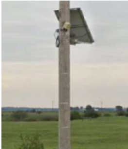
Sample Actual Installation
